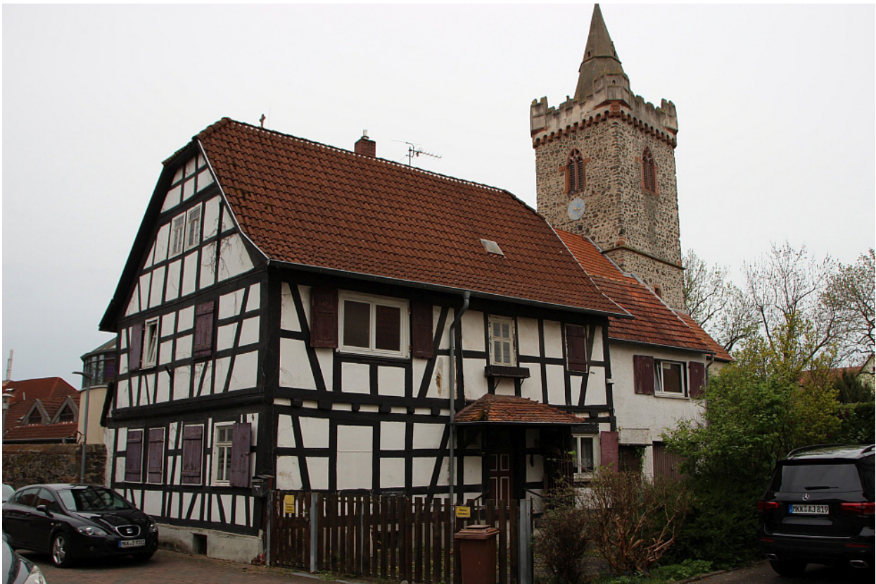
Abb. 50: Gebäude in der Martin-Luther-Straße 4
